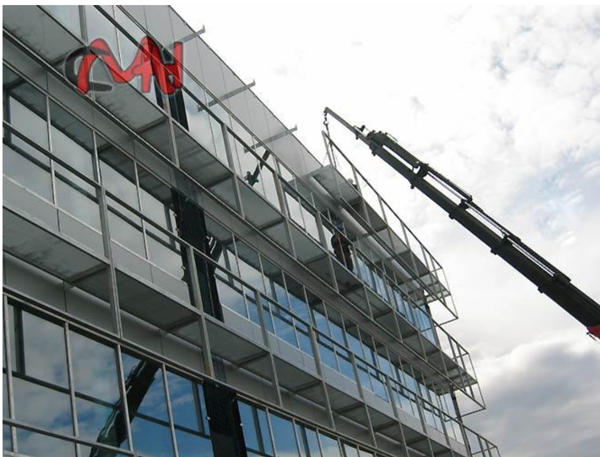
Pasarela en fachada de Acero galvanizado
